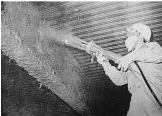
鉄骨梁への吹き付け塗装
