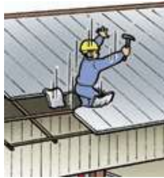
「屋根の踏み抜き・墜落」
