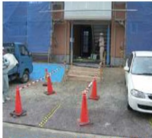
* トラテープで敷鉄板の段差も改善
