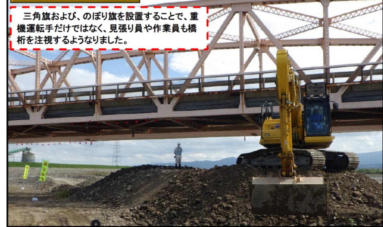
桁下範囲作業状況
